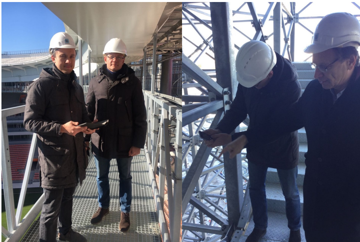
Рис.3.29. Специалисты Научно-исследовательского центра СтаДиО. Фотография стадиона в г. Екатеринбург во время строительства (по состоянию на октябрь 2017г.)
