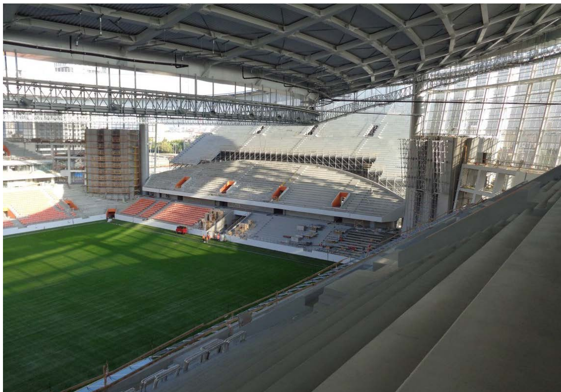
Рис.3.25. Фотография стадиона в г. Екатеринбург во время строительства (по состоянию на октябрь 2017г.)
