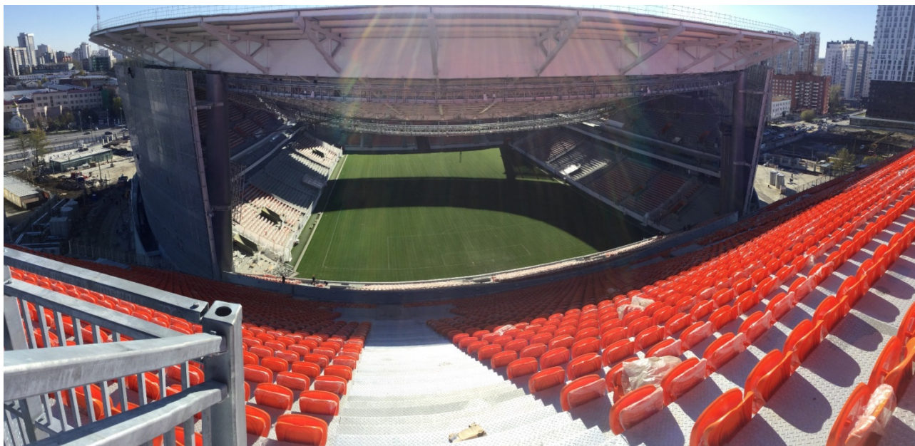
Рис.3.27. Фотография стадиона в г. Екатеринбург во время строительства (по состоянию на октябрь 2017г.). Вид с временной сборно-разборной трибуны.
