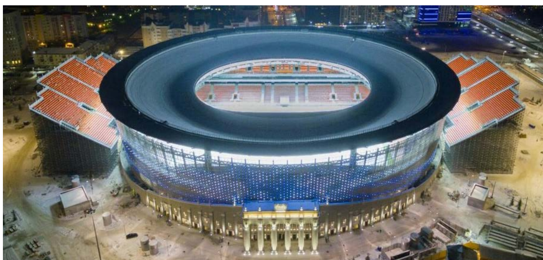
Рис.3.24. Фотография стадиона в г. Екатеринбург (декабрь 2017г).
