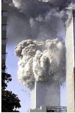
Разрушение башен ВТЦ
