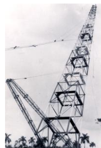
Куба, монтаж опрокидыванием
