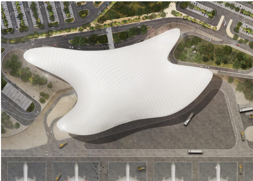
Аэровокзальный комплекс в г. Геленджик
