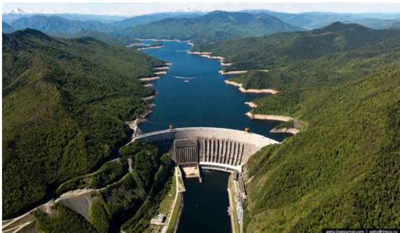
Гидроузел СШГЭС им. П.С. Непорожного
