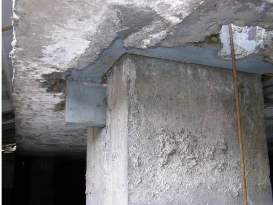
Устройство опирания вневольных плит перекрытий на колонны
