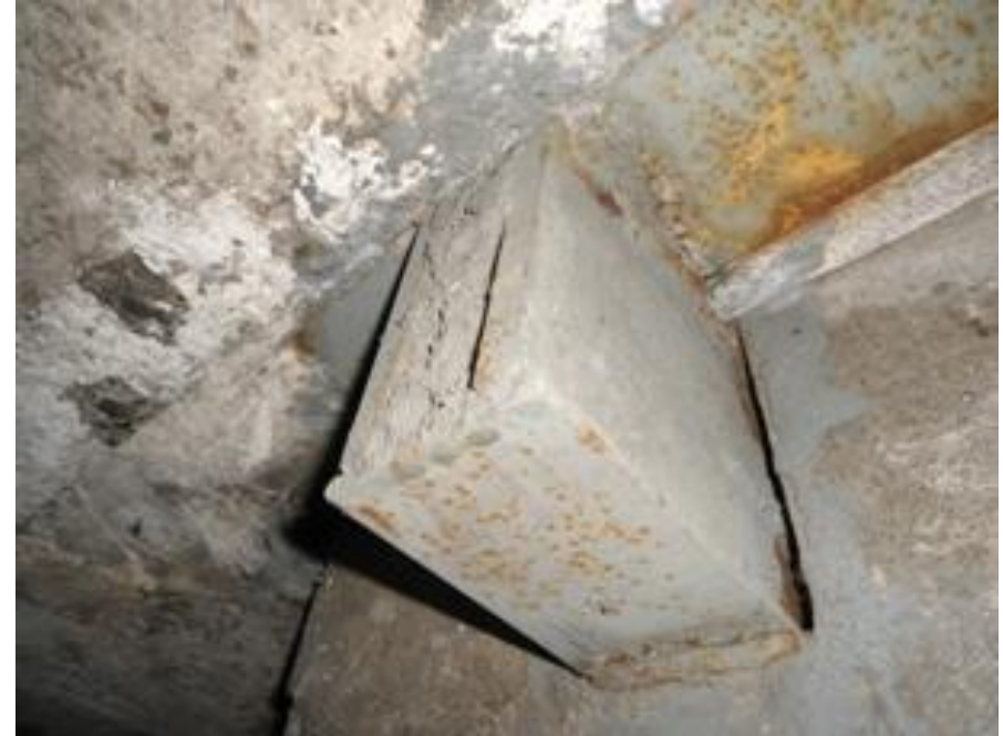
Устройство опирания вневольных плит перекрытий на колонны
