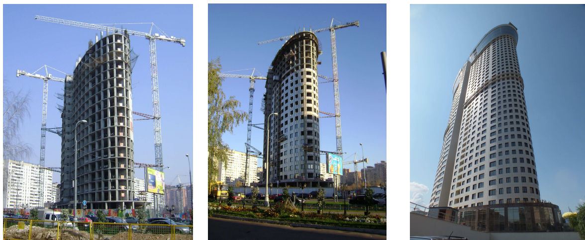
Рис.5.4. Высотный комплекс «Дирижабль». Этапы строительства
